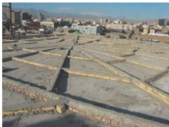
شکل ۱۴ ▲ کرم‌بندی و شمشه‌گیری بین آن‌ها
