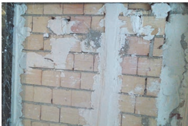
شکل ۲۴ ▲ شمشه‌گیری بین کرم‌ها
