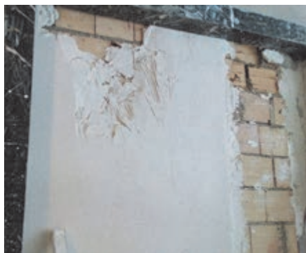
شکل ۲۵ ▲ پر کردن متن بین شمشه‌ها
