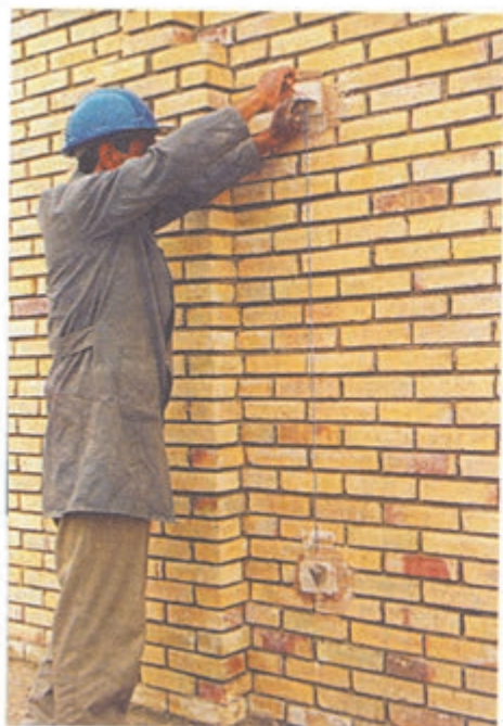
▲ شکل ۲۰ شاقولی کردن کرم‌ها
