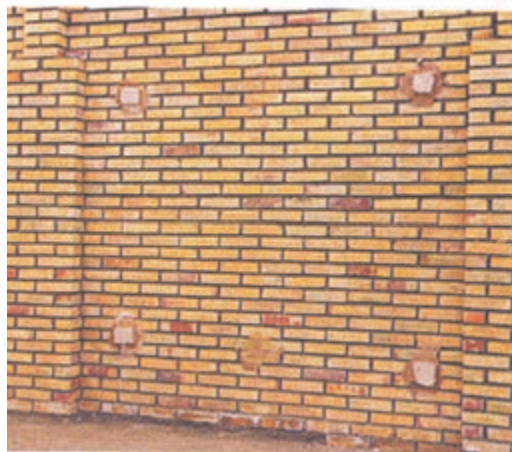
▲ شکل ۲۱ کرم‌بندی ابتدا و انتهای دیوار
