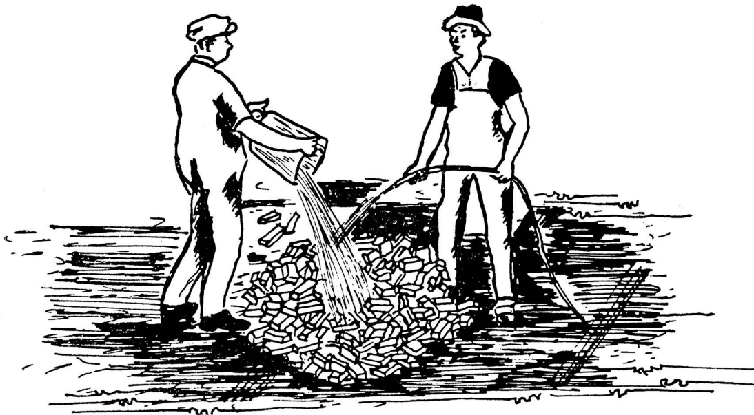
شکل ۳۷ ▲ زنجاب کردن آجر
